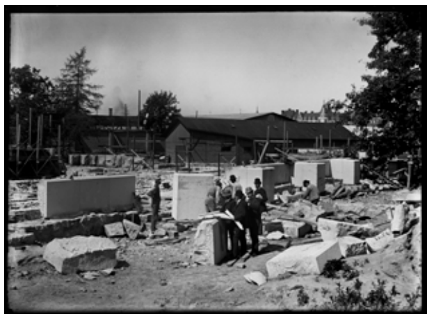
Byggarbetsplatsen 1892. Granitblocken för grunden är på plats.
