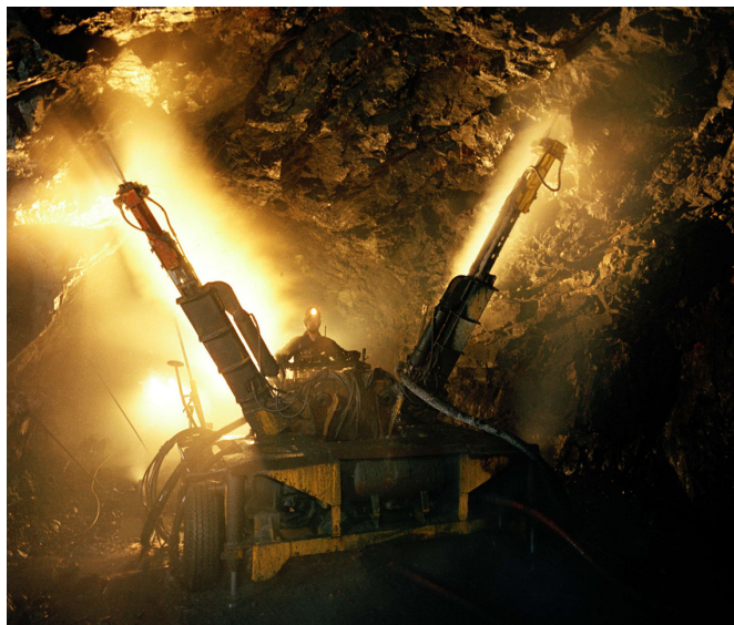
GRUVDRIFT MED GRUVBORRMASKIN.
